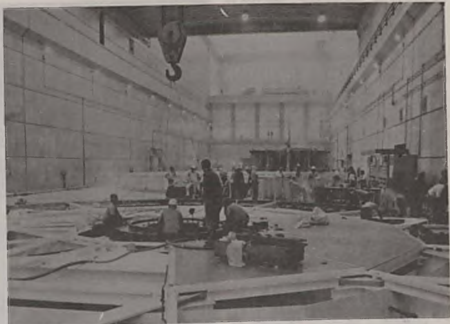
FIGURA 4: A montagem dos geradores
