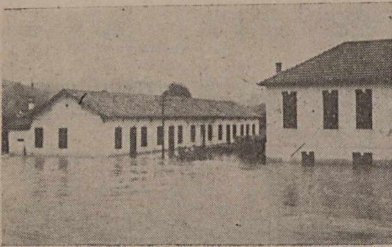
Casas atingidas, nas margens do Pirai, vendo-se o vestígio da altura atingida pelas águas do rio Paraíba
