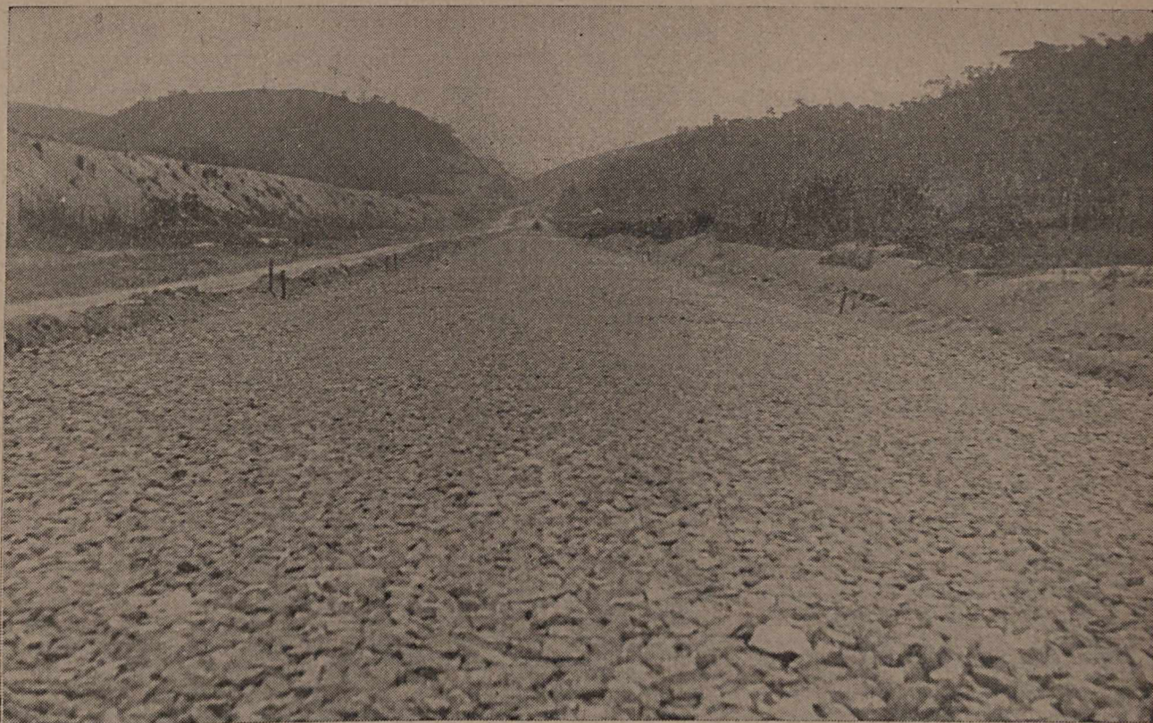
Trecho empedrado da rodovia ainda em construção
