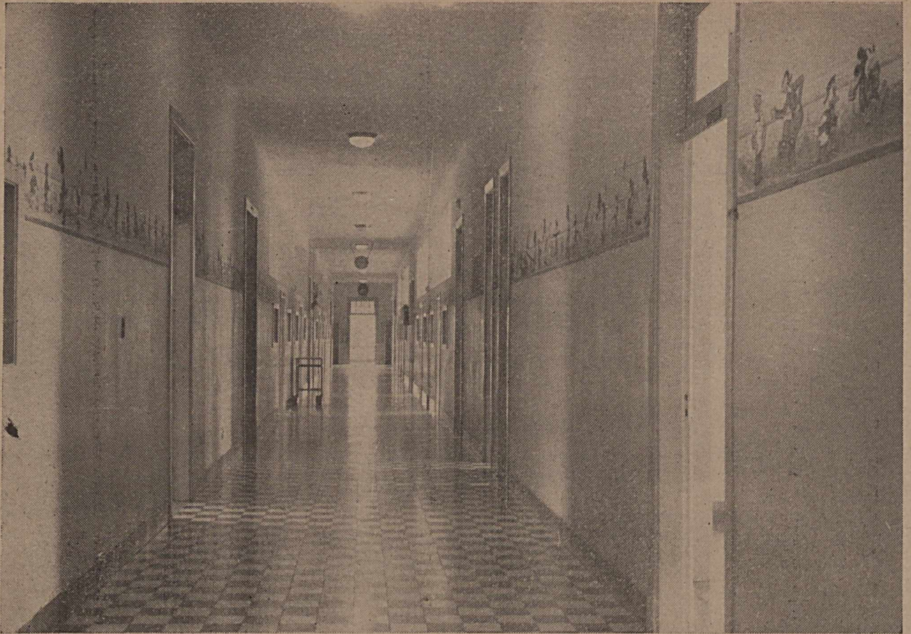
Fotografia n.º 7 — Entrada para a Clínica Pediátrica. Notem-se as dimensões do corredor, o sistema de iluminação e ventilação, o relógio elétrico e o extintor de incêndio para um caso de emergência.
