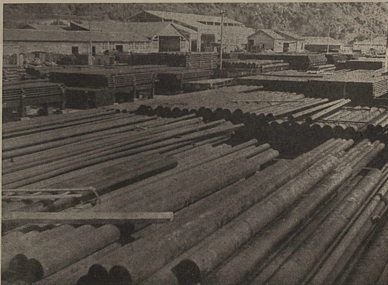
Material depositado em Jequitaita, Salvador — Bahia. Ao fundo, o edifício da nova oficina mecânica
