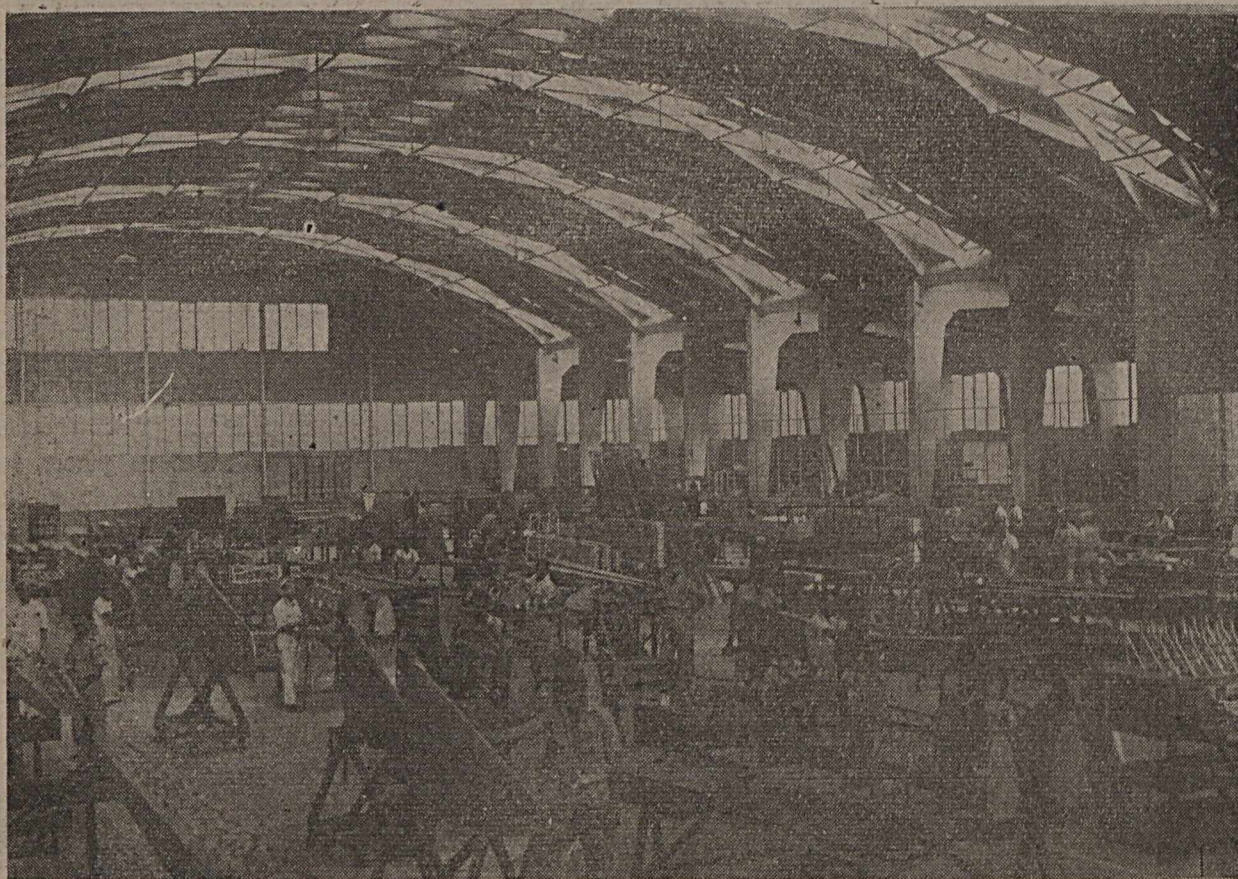
Carpintaria, onde são confeccionados, em madeira, estabilizadores, asas, flaps, quilhas, etc.
