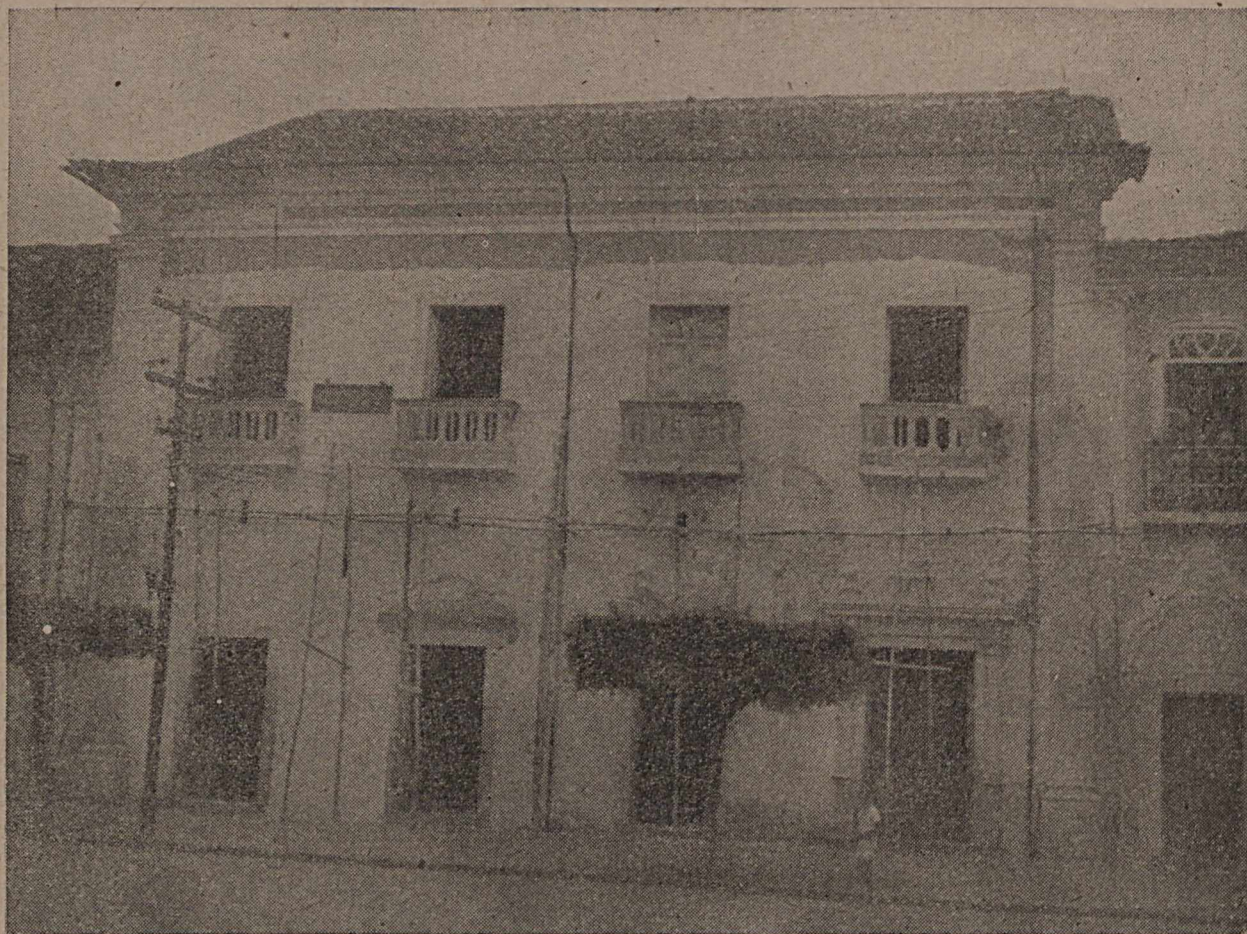
Sobrado à Praça da Aclamação, 4, em Cachoeira, Estado da Bahia. — Aspecto geral do andamento das obras de restauração empreendidas pelo S.P.H.A.N. — Notar os telhados já reparados, as trincaduras de vergas já costuradas e a cantaria das cercaduras devidamente raspada.
