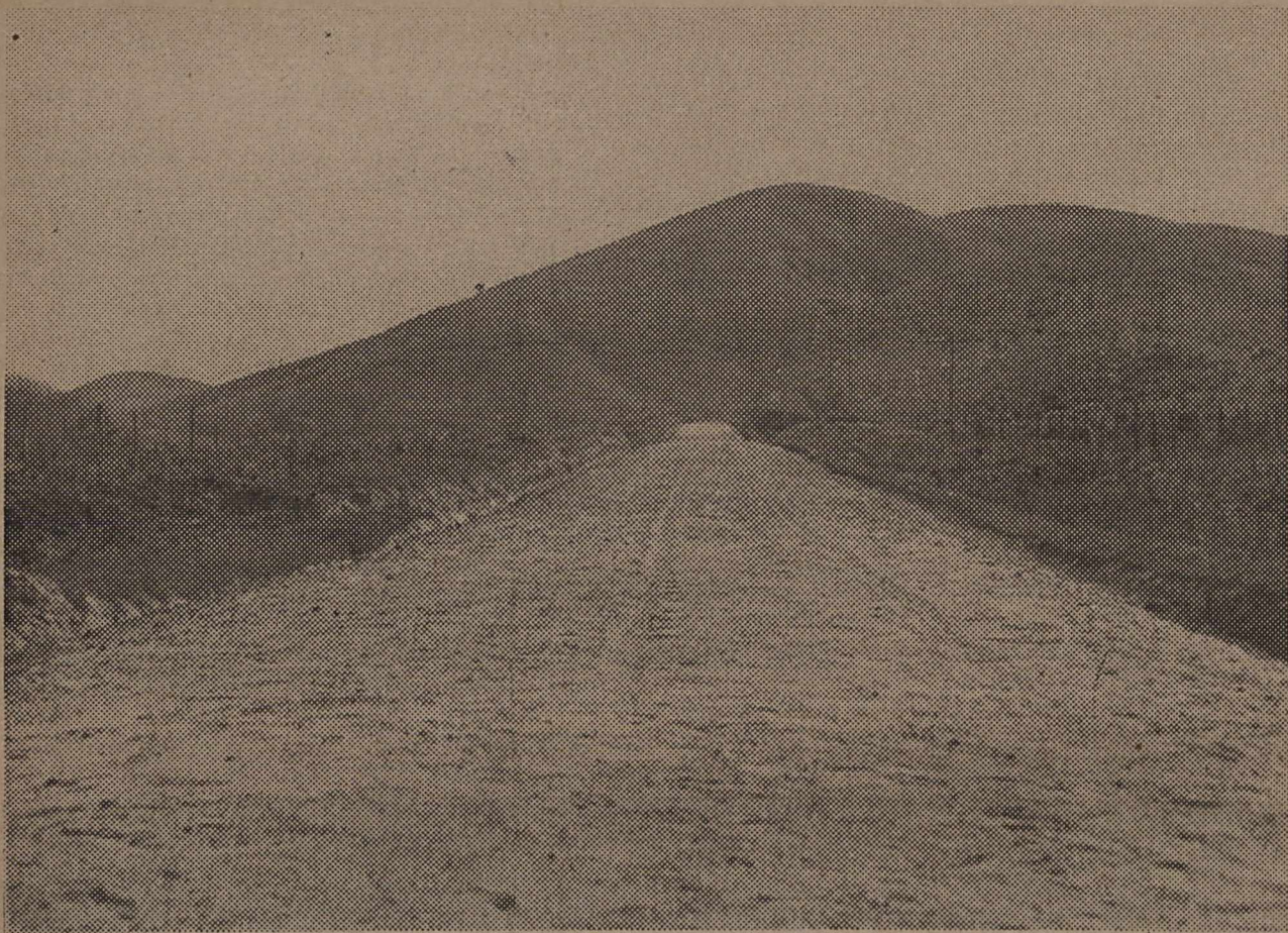
LIGAÇÃO DA ESTRADA RIO-S. PAULO A ANGRA DOS REIS — Reta do trecho já concluído, situado entre a Garganta da Piriti e a Vila Parado.
