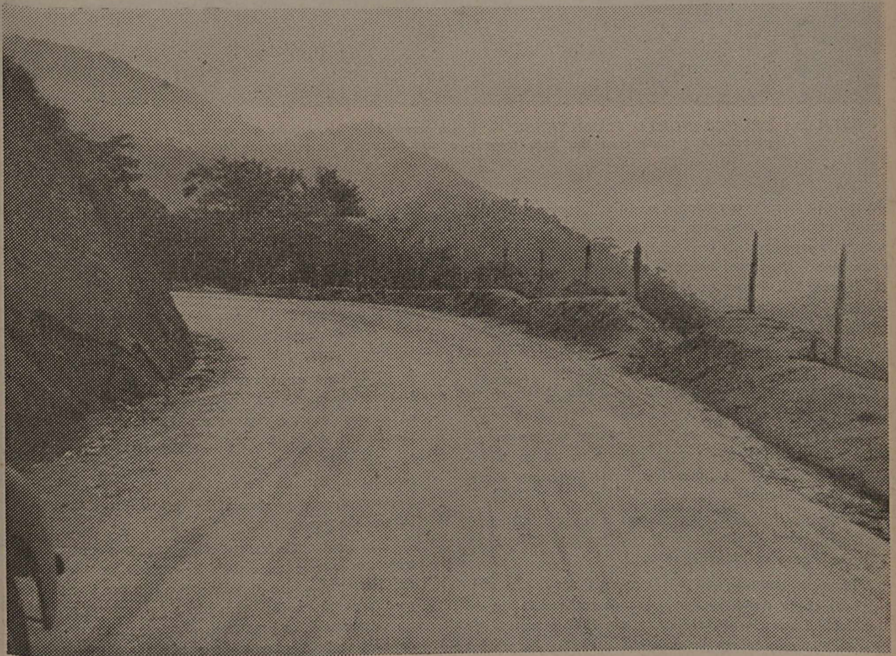
ESTRADA TRONCO NORTE FLUMINENSE — Trecho da Serra de Friburgo, mostrando a pista branca da estrada, conseguida depois de executado o revestimento com um moledo especial.
