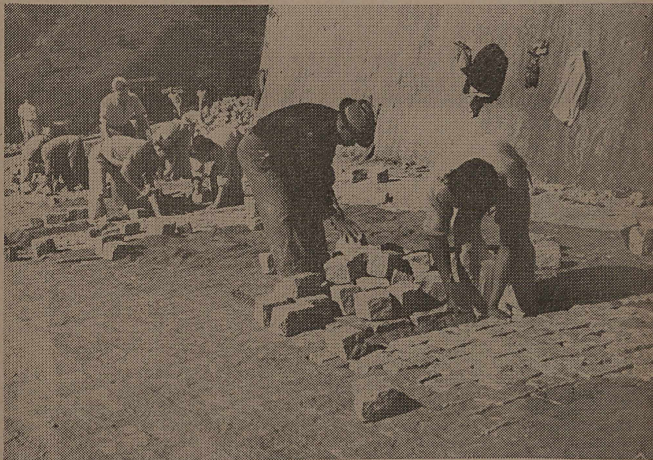
LIGAÇÃO DA ESTRADA RIO-S. PAULO A PAULO DE FRONTIN E MENDES — Execução do calçamento a paralelepípedos, no trecho da serra, compreendido entre Paracambi e Paulo de Frontin.
