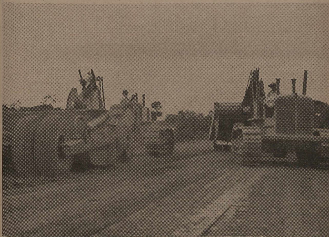
ESTRADA TRONCO PRINCIPAL — Aparelhamento mecânico da Comissão de Estradas de Rodagens em trabalho na construção dessa estrada, no trecho entre Manilha e Itaboraí,
