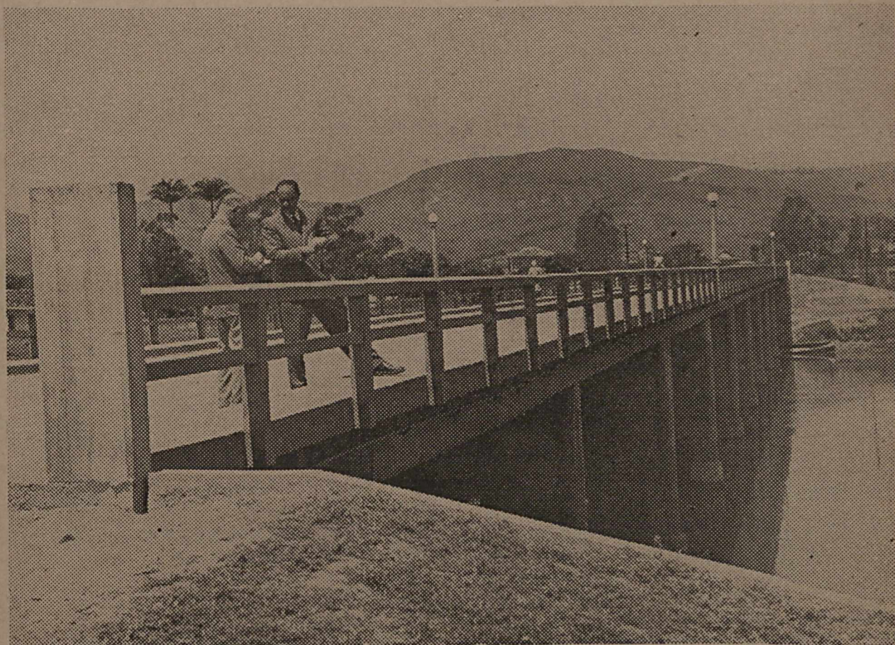
ESTRADA TRONCO VALE DO PARAIBA — Ponte General Escudero, sobre o rio Paraíba, defronte da estação de Vargem Alegre, na Central do Brasil. Essa ponte tem 120 metros de vão, 8,30 de largura e servirá à comunicação do futuro grande centro siderúrgico de Volta Redonda com Barra do Piraí, Vassouras, Paraíba do Sul, Entre Rios e a estrada União e Indústria.
