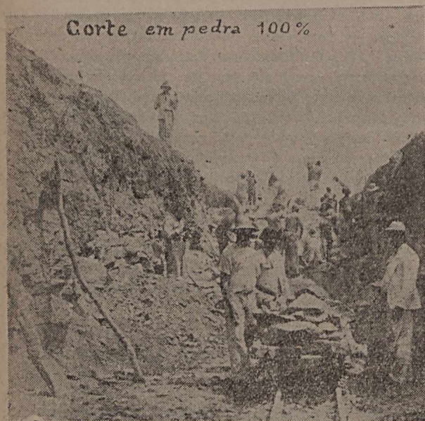
TRECHO DE ITAÍBA A MUNDO NOVO — Corte em pedra
