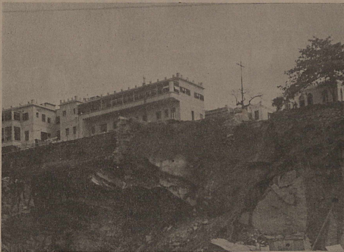
Vista geral, do lado do mar
