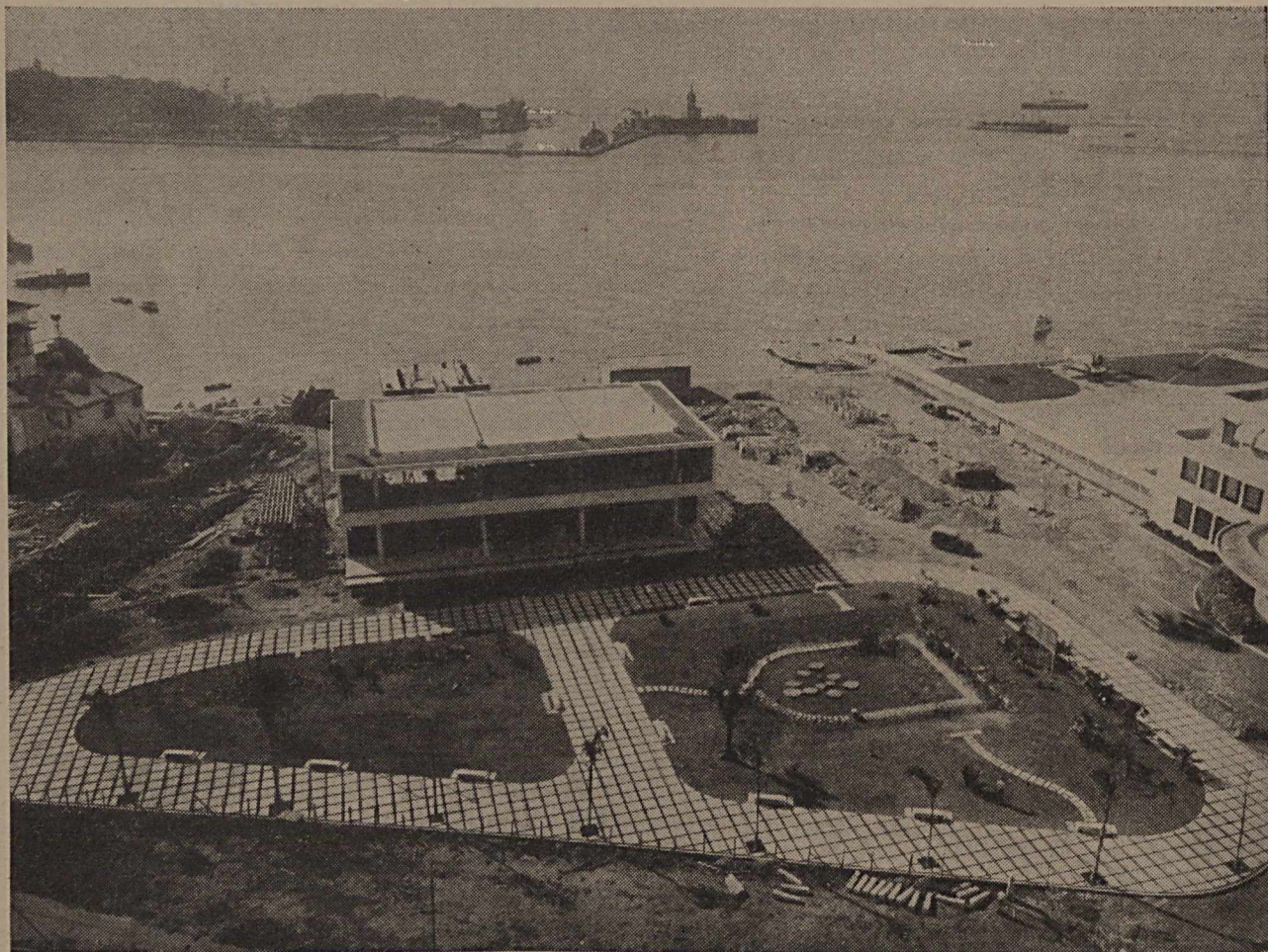
A estação de Hidro Aviãos do Aeroporto Santos Dumont
