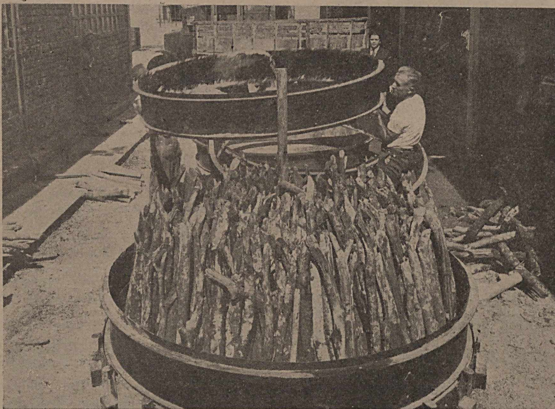
Experiência de carbonização em fornos desmontados — Rendimento de 30%, 16% superior ao rendimento do processo das medas, usado entre nós.
