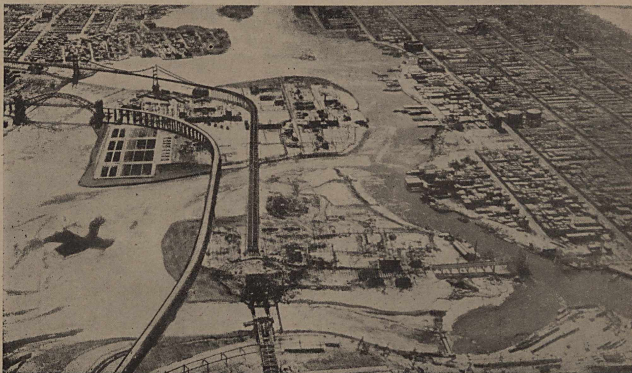
Fig. 1 — A grande ponte dos tres bairros, em New York, e a estação depuradora de esgotos da Wards Island
