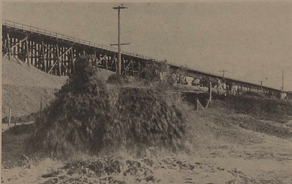
Fig. 5. — O aterro hidráulico construindo a maior barragem de terra do mundo, Fort Peck Dam, no Estado de Montana.
