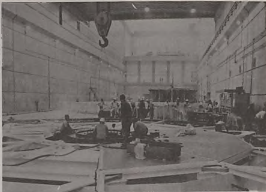
FIGURA 4: A montagem dos geradores
