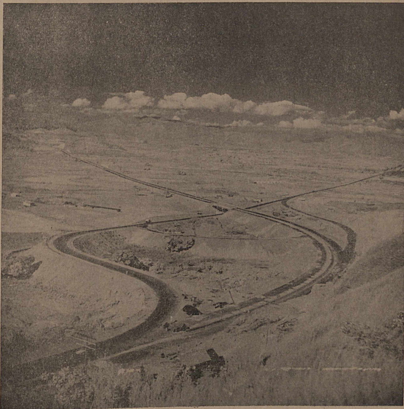
Vista aérea do trevo da rodovia Presidente Dutra
