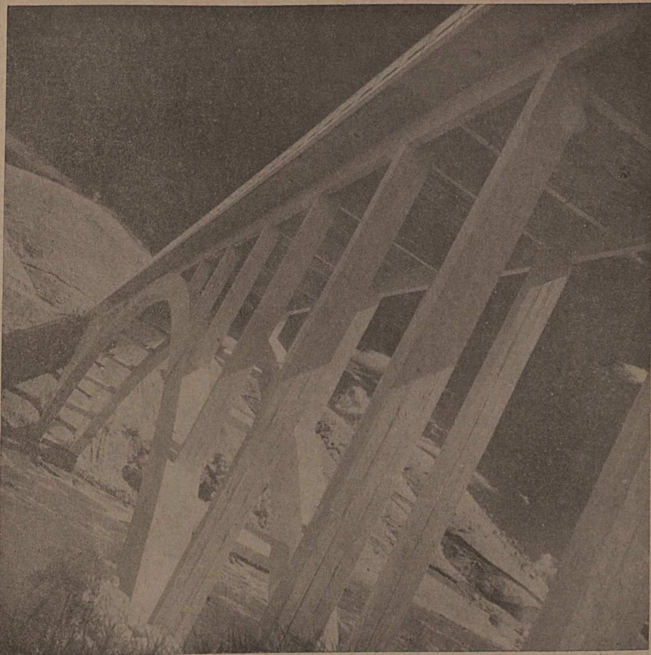
Vista de uma ponte na Rodovia Presidente Dutra
