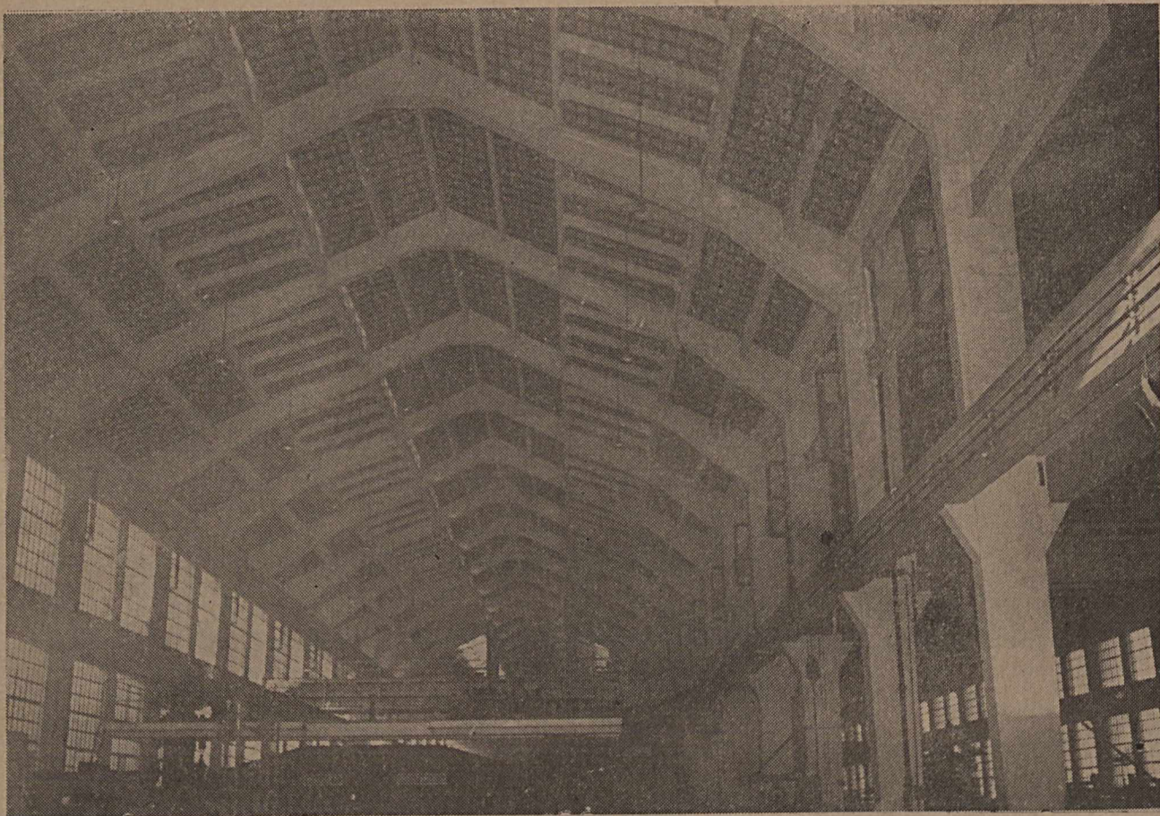
Interior do edifício n.º 19 — depois de Volta Redonda é área coberta de oficina mais extensa do Brasil
