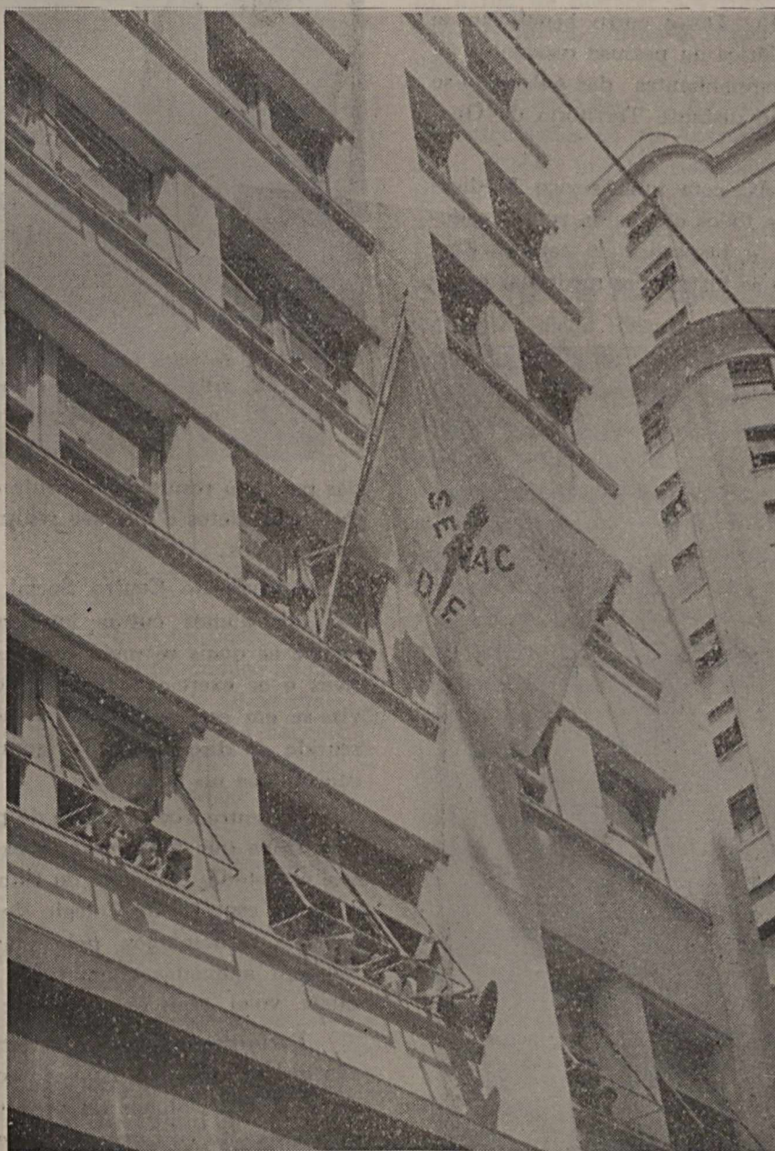
A sede do SENAC carioca está instalada em três amplos andares do Edifício VASP, situado na rua Santa Luzia, 735, perto da Cinelândia
