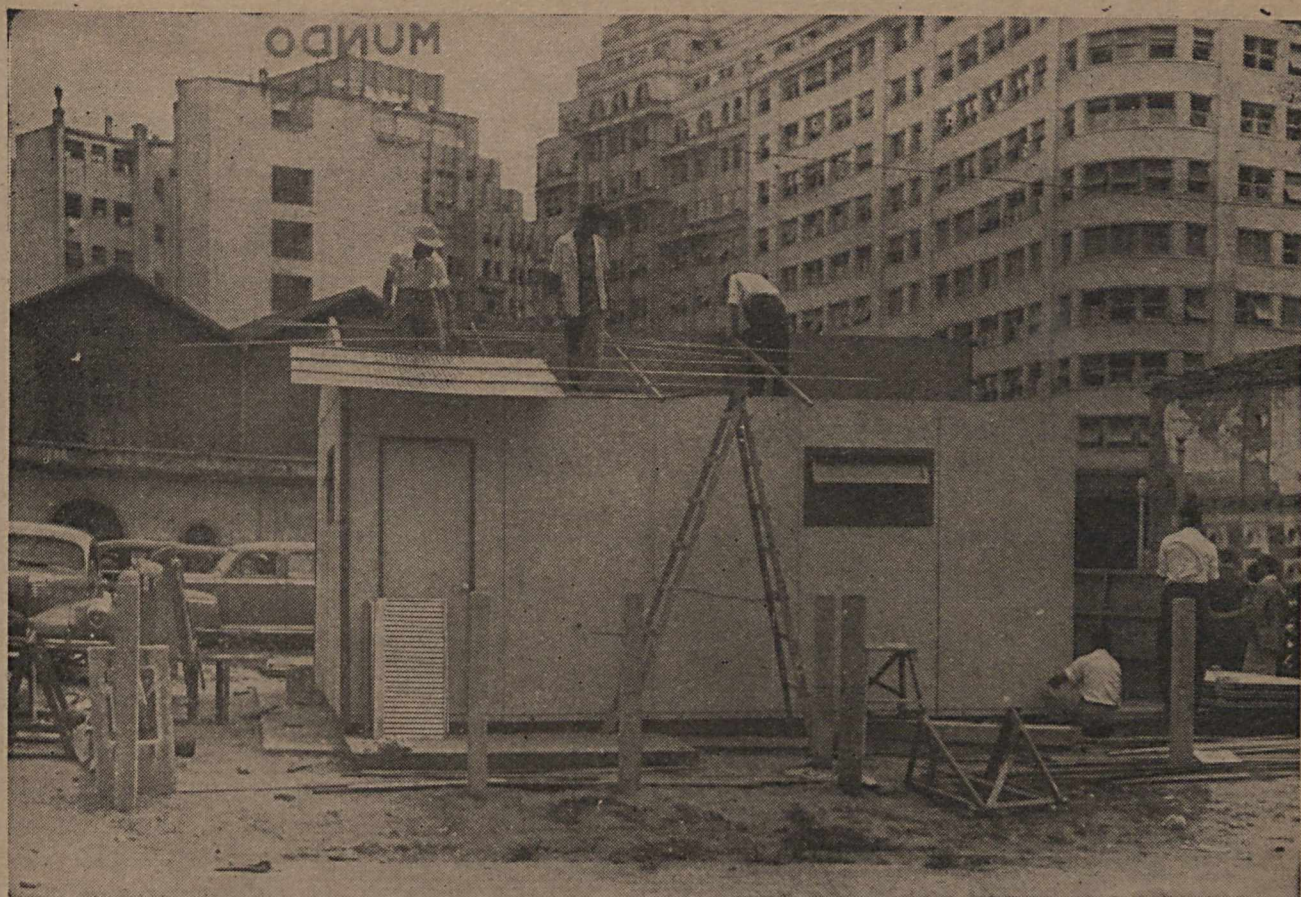
A casa em construção
