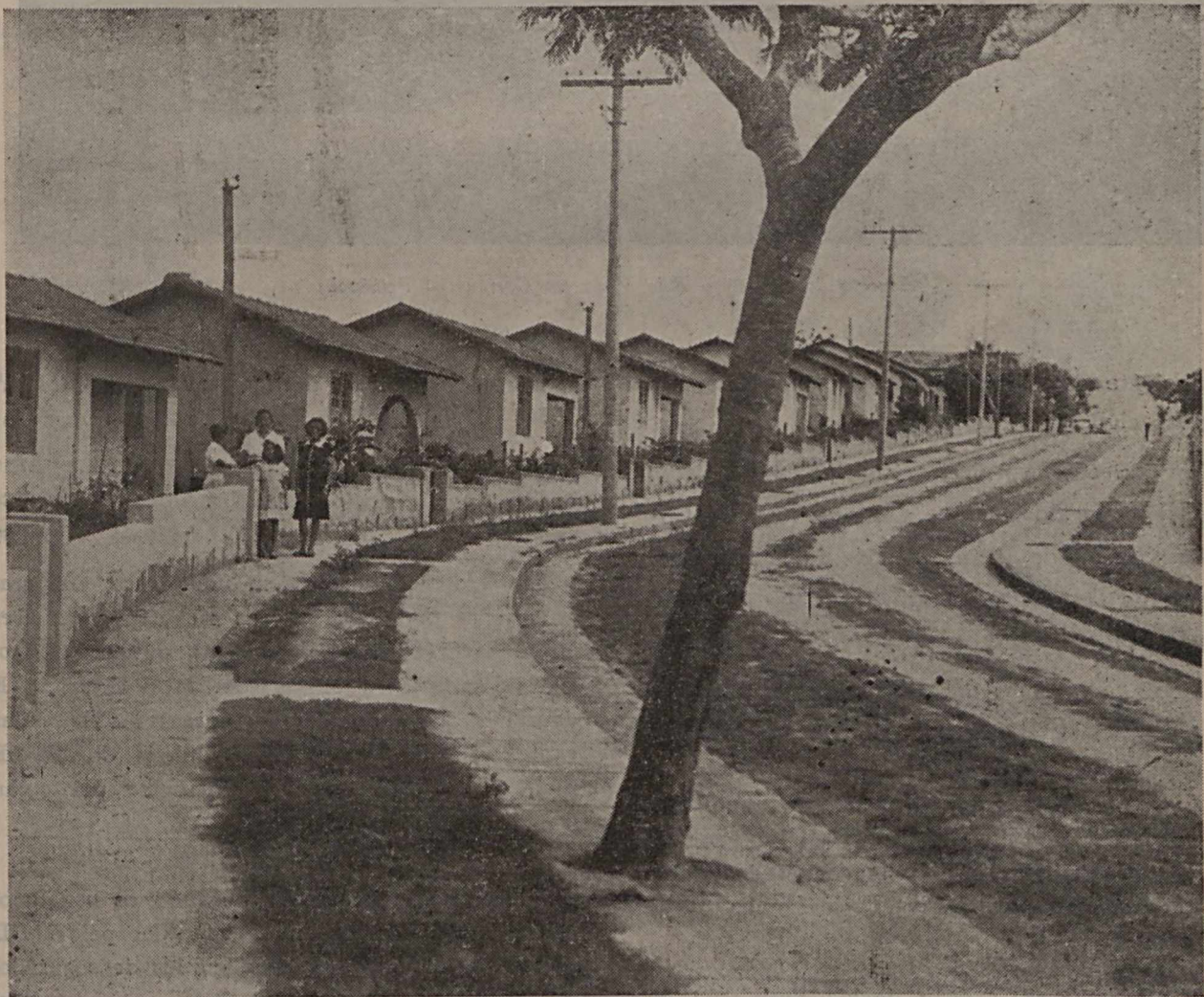
Vila de casas em Campo Grande
