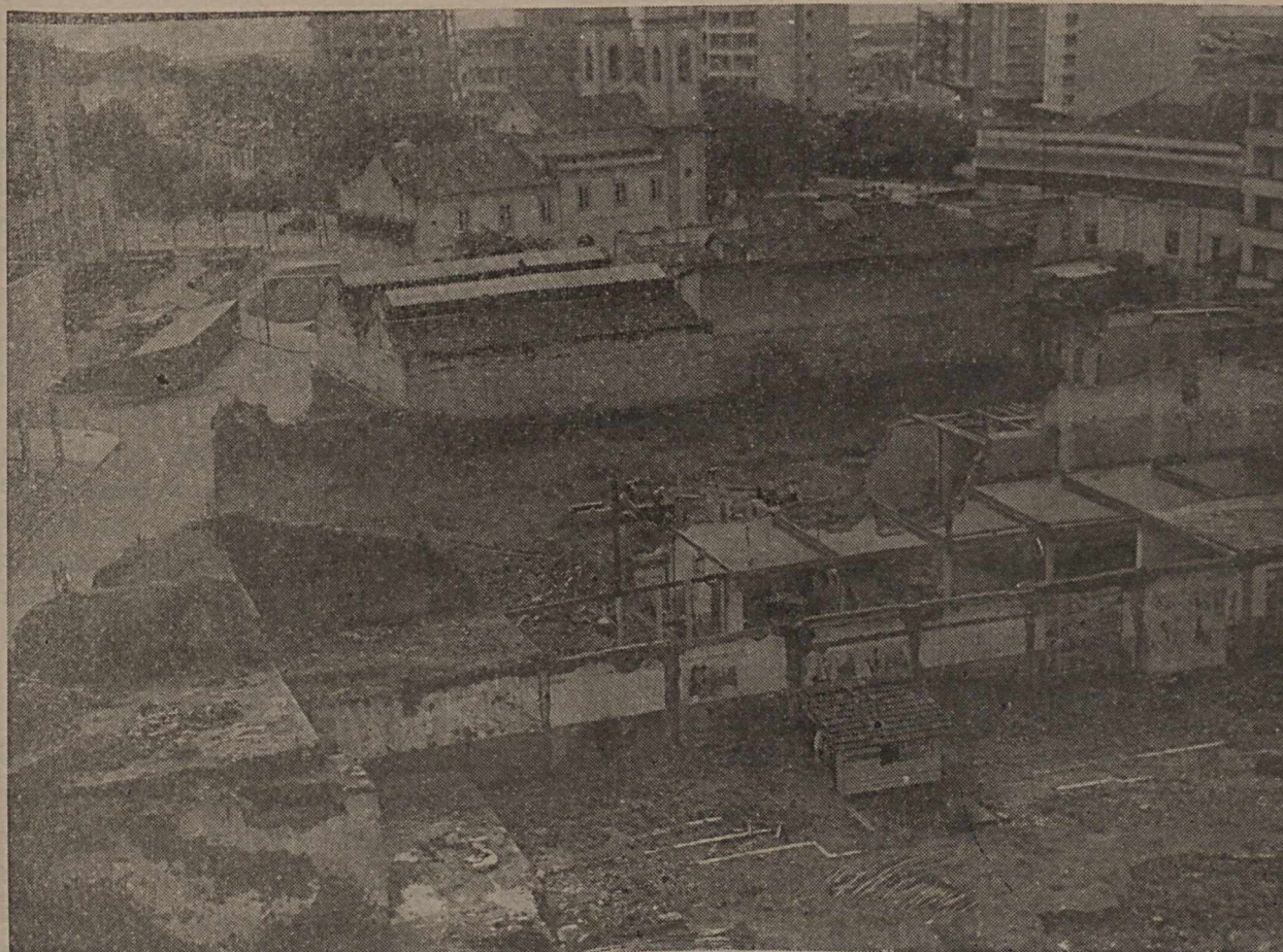
Demolições para formação da área destinada à praça ajardinada fronteira ao edifício.
