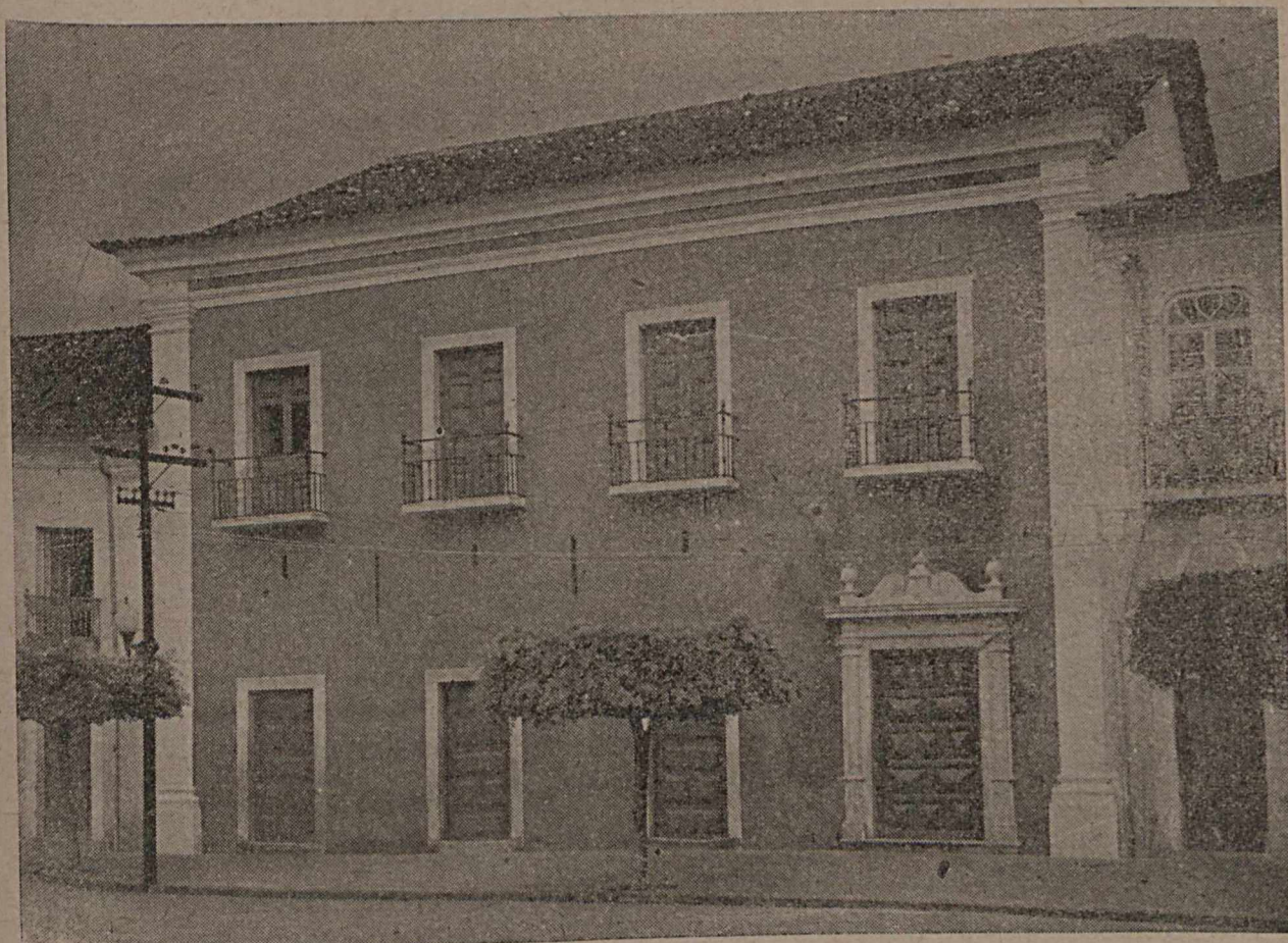
O mesmo sobrado (casa-nobre), restaurado recentemente a expensas e sob orientação técnica do S.P.H.A.N. — Tem a fachada principal pintada de cor de rosa; as portas e janelas, pintadas de verde; e as grades, que são novas, mas iguais às primitivas, de negro fosco. A portada, as bacias das sacadas, as cercaduras de portas e janelas, foram raspadas cuidadosamente e lavadas, ficando à mostra seu fino e alvo lioz. As calhas e condutores foram retirados. Outros serviços de restauração, menores, foram realizados no solar em aprêço, que é dos mais significativos e fortes da cidade de Cachoeira. Notar, a meia altura do cunhal à esquerda, a data 1723 aberta na pedra.
