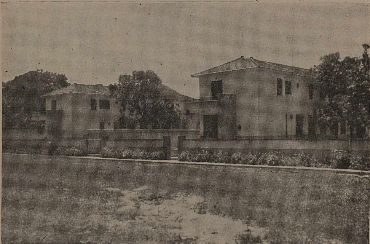
INSTITUTO PROFISSIONAL 15 DE NOVEMBRO — Duas das casas-lares, construídas próximo da sede principal do Instituto e que serão destinadas a debses mentais para sua educação individual
