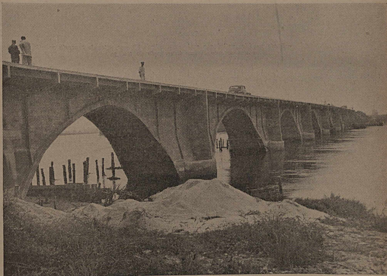
ESTRADA LITORÂNEA DE MACAÊ — Ponte sobre o rio S. João, grande obra de 150 metros de vão, formada por uma série de arcos em concreto armado.
