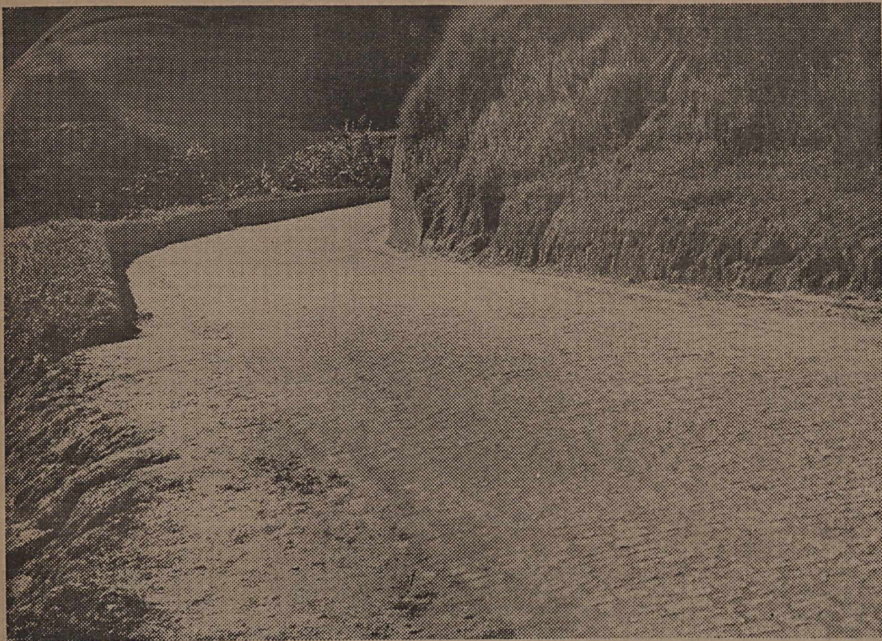
LIGAÇÃO DA ESTRADA RIO-S. PAULO A PAULO DE FRONTIN E MENDES — Trecho já calçado a paralelepípedos, a fim de assegurar melhor tráfego a essa estrada na serra de Paracambi, por onde transitam todos os veículos entre a estrada Rio-S. Paulo e as localidades de Paulo de Frontin, Mendes, Vassouras, Barra do Pirai e Valença.
