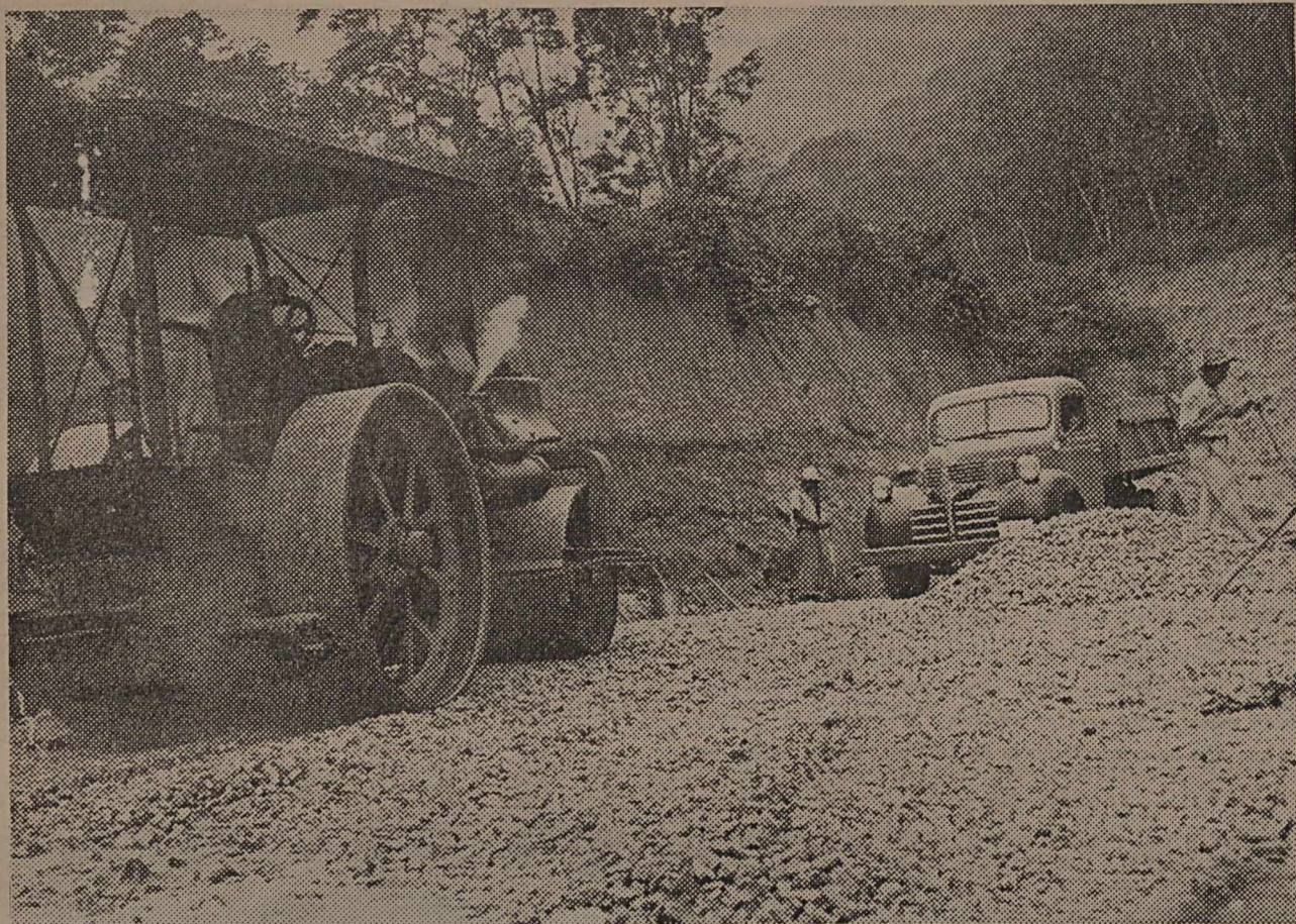
ESTRADA LITORÂNEA DE MACAÉ — Trecho da Serra de Mato Grosso, vendo-se o serviço de macadamização, que está sendo feito para maior segurança e conforto do tráfego.
