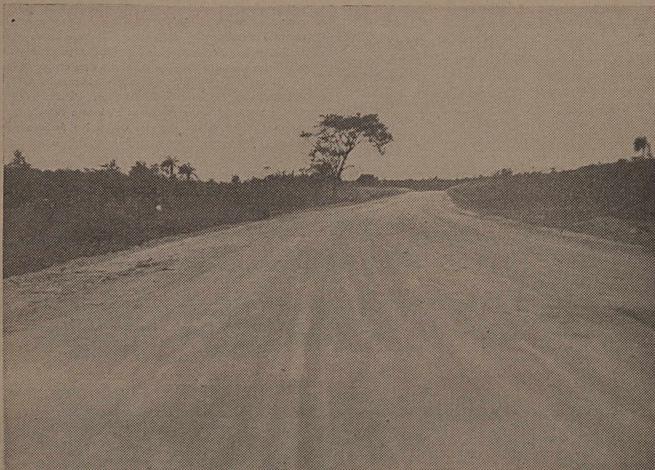
ESTRADA TRONCO PRINCIPAL — Trecho já concluído em que a construção permite ampla visibilidade.
