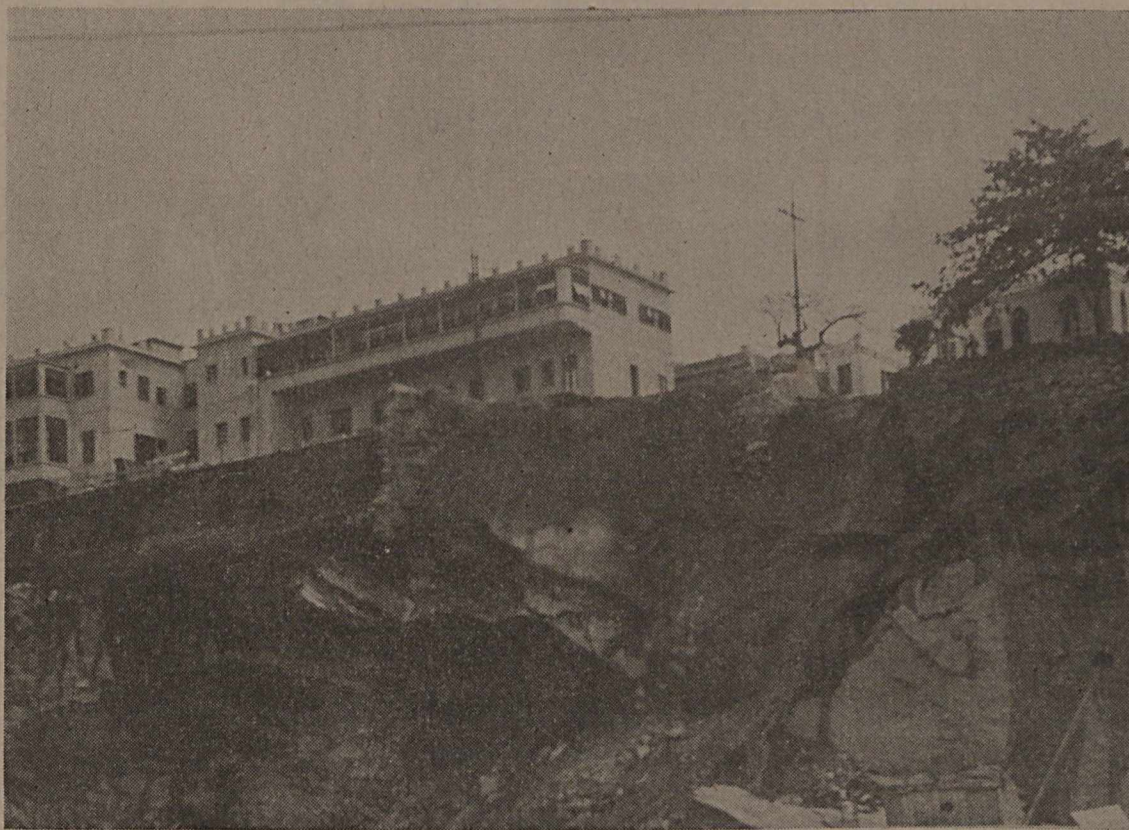
Vista geral, do lado do mar
